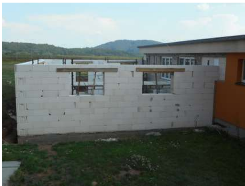
Obvodová zeď nové kuchyně
