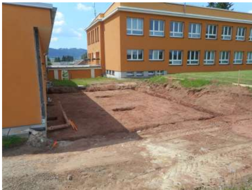
Výstavba nové kuchyně
